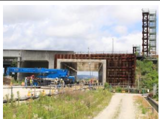
現在、岩切地区仙台バイパスのアンダーパス線路工事中(23年6月)
