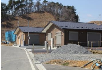
石巻市災害公営住宅（戸建て）
