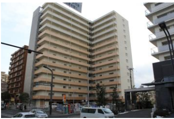
仙台市災害公営住宅（集合）
