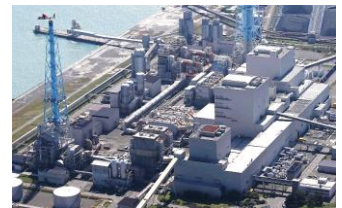
発電停止した 苫東厚真火力発電所
