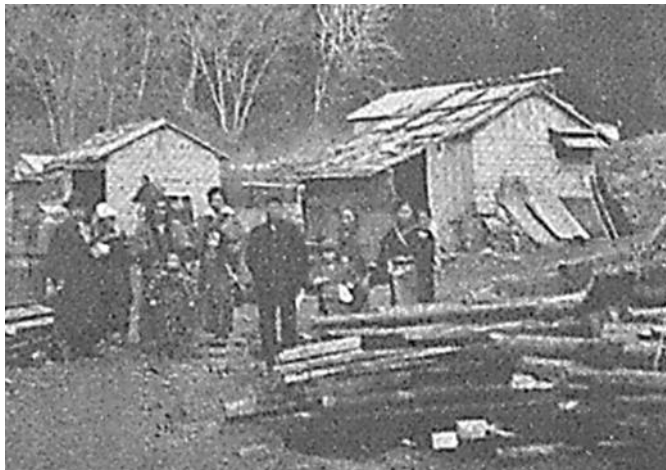
十五浜雄勝のバラック（仮設住宅）
