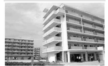
7月12日完成した閑上地区の災害公営住宅（朝日新聞7.13より）
