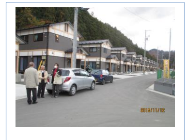
大槌町 戸建て2階建ての災害公営住宅
