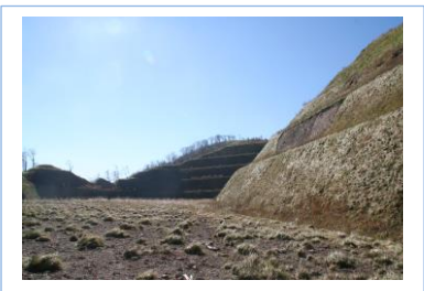
候補地法面 勾配は 5 1 度。
