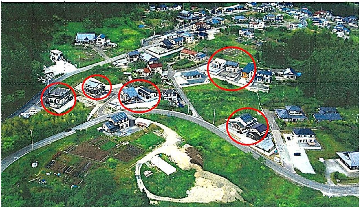
大船渡市末崎 梅神地区の差込型防災集団移転（13戸） ○印住宅が既存宅地に差し込まれるように建設された住宅（写真外にも4戸建設）
