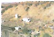
厚良町（高野地区）の被災状況
