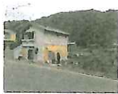
住居が壊れず、トイレが壊れたままの住宅
