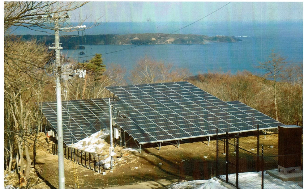
大六天発電所(NPO法人 おながわ・市民共同発電所) 開設日:平成30年2月6日 社団法人女川町高白浜字向山 全量買取制度利用・280wパネル264枚 73.92kwシステム 販売施工 株式会社プロジェクトウサミ
