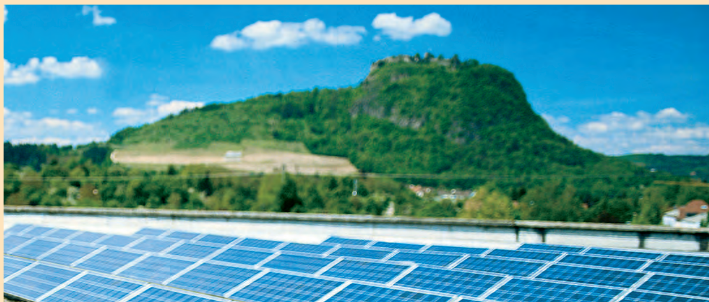
2001年に設置されたソーラーコンプレックス初の太陽光パネル：18kW-ジンゲン市フリードリヒ・ヴェーラー・ギムナジウム。設置単価1kW当たり5,000ユーロ – 現在の1kW当たりコストはほぼ4分の1になった。それ以来、21,000kWが送電網に接続されている。
