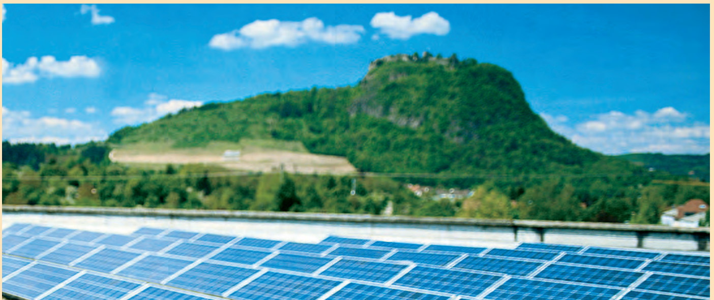
Die erste PV-Anlage von solarcomplex im Jahr 2001: 18 kW auf dem Friedrich-Wöhler-Gymnasium in Singen. Die Installation eines kW kostete rund 5.000 Euro - heute kostet 1 kW noch ein Viertel davon. Seitdem gingen über 21.000 kW neu ans Netz.
