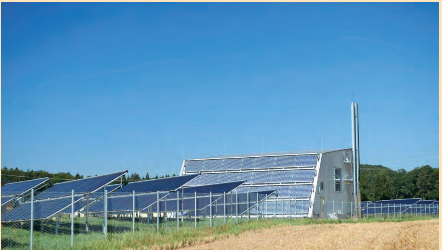
ピュッシンゲン・バイオエネルギー村 - 1000m 2 の太陽熱集熱器を併設した熱供給システム
