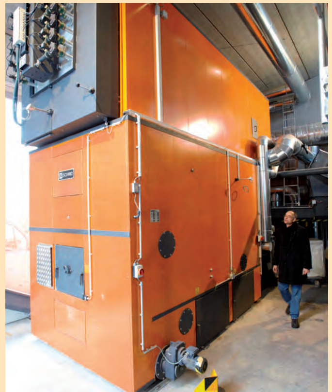
ラントエックのセントラル・ヒーティングシステム。出力2MWの木質チップボイラー
