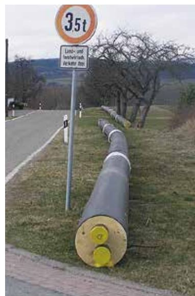
地域熱供給網に用いる給湯パイプ(ソーラーコンプレックスのホームページから)
